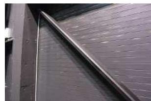
小ホールの奥のシャッターには風によりシャッターが揺れて音が出ないように棒が取り付けられています。
